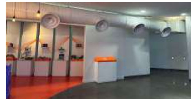
Nouvelle installation de pompes à chaleur dans la zone d'accueil du musée
